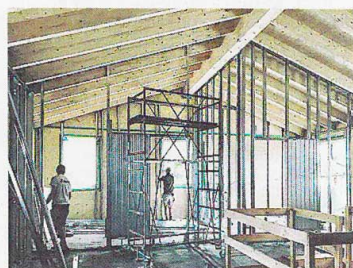
Lavori in corso A sinistra come sarà il nuovo villaggio residenziale, sopra la costruzione di una casa: in una settimana si conclude l'intera struttura perimetrale
